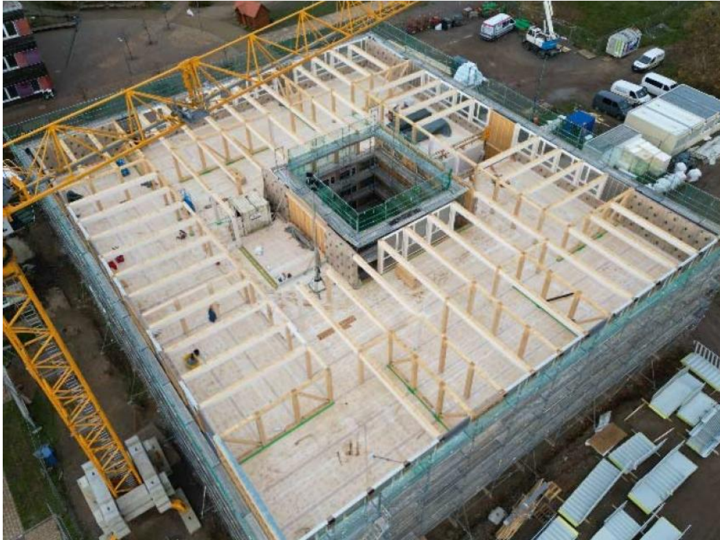
Bild 3: Nach dem Aufbau der vorgefertigten Holzmodule. © Edith-Stein-Schulstiftung, Magdeburg. Foto: Sven Gora
