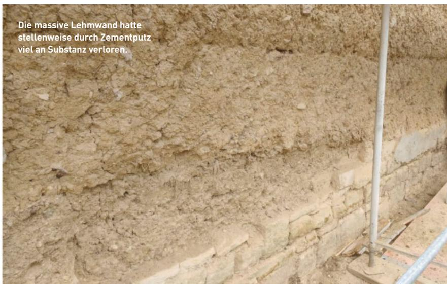
Die massive Lehmwand hatte stellenweise durch Zementputz viel an Substanz verloren.
