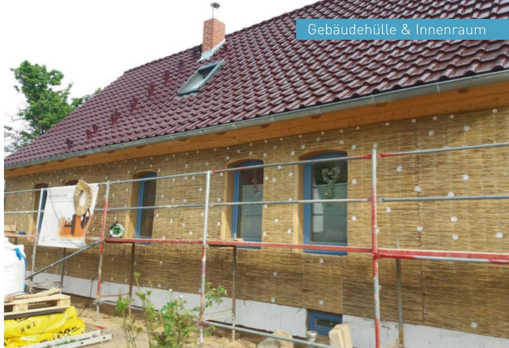
Dünne Dämmplatten aus Schilf bilden den tragfähigen Untergrund für den dickschichtigen, gänzlich biozidfreien Kalkputz.
