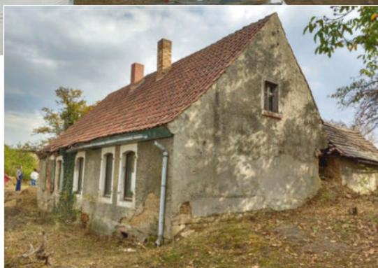
Zustand des Lehmwellerbaus in Klobikau mit einer komplett weggebrochenen Wandecke. Im Inneren war die Luftqualität allerdings gut. Der typische Altbaugeruch fehlte.
