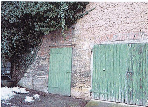
Scheune des Vierseitenhofs in der Ölgasse im Norden Gleinas, 2021 © GOLEHM
