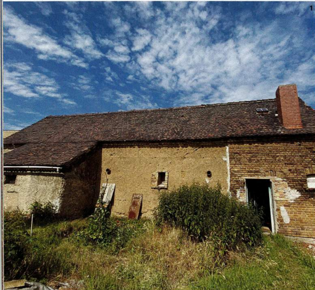
1 Beim Umbau der alten Scheune standen Klimawandel, ökologisches Heizen und das Baumaterial im Fokus. 2 Lehm war früher ein gängiges Baumaterial für Häuser und Scheunen. Inzwischen feiert der natürliche Baustoff sein Comeback. 3 Lehm dichtet den Spalt zwischen Drempel (auch als Kniestock bekannt) und Dachsparren ab und gleicht Feuchtigkeitsunterschiede aus.
