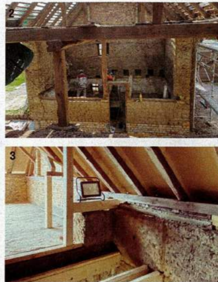
1 Beim Umbau der alten Scheune standen Klimawandel, ökologisches Heizen und das Baumaterial im Fokus. 2 Lehm war früher ein gängiges Baumaterial für Häuser und Scheunen. Inzwischen feiert der natürliche Baustoff sein Comeback. 3 Lehm dichtet den Spalt zwischen Drempel (auch als Kniestock bekannt) und Dachsparren ab und gleicht Feuchtigkeitsunterschiede aus.
