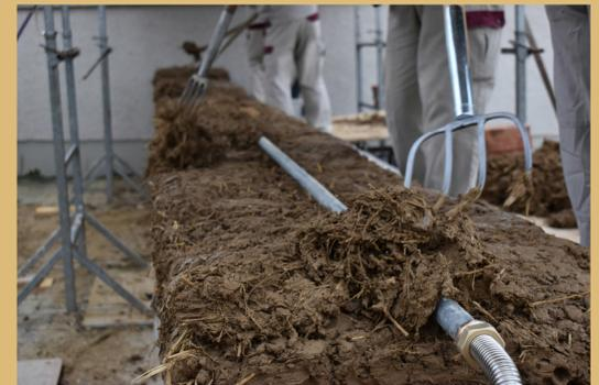
In den Wellerlehm-Wandmodulen wurden verschiedene Arten von Heizrohren eingebaut. Die Variante mit Edelstahlflexrohren erwies sich aufgrund der damit möglichen Endlosverlegung als die praktikabelste Anwendung.
